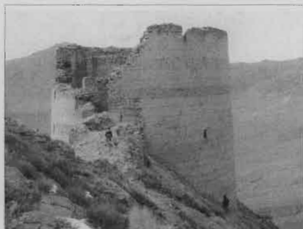
تصویر ۱۷- برج چهل خانه - فضای داخلی
