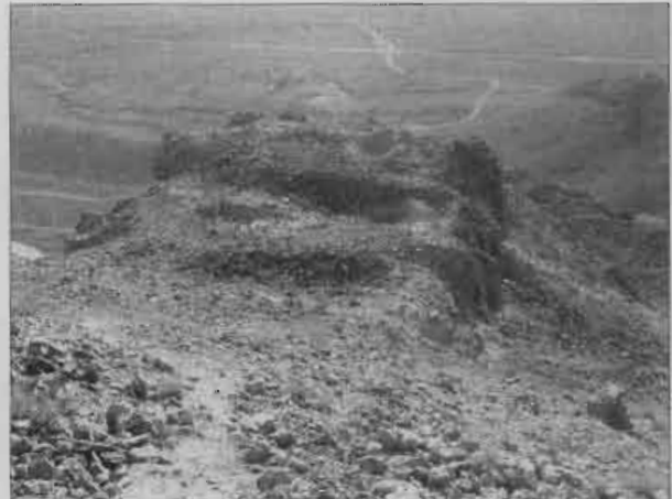
تصویر ۷- سطح تخریب شده
