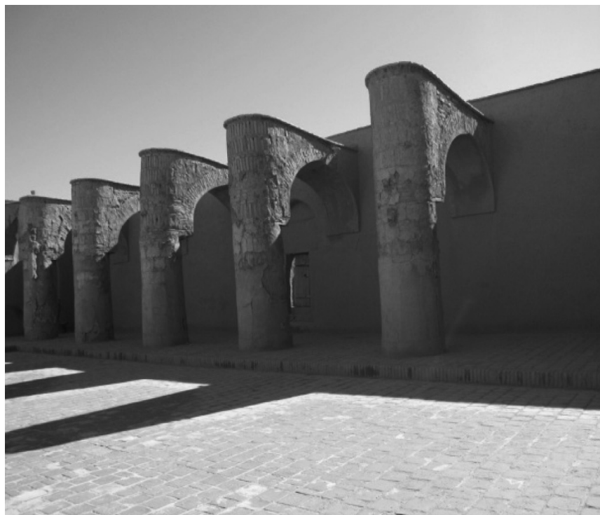
تصویر شماره (۴): رواق ضلع شرقی مسجد تاریخانه
